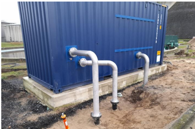
S::Select®-Anlage KA Borken (130.000 EW), Anschlussarbeiten Rohrleitungen, Container auf Fundamentplatte
