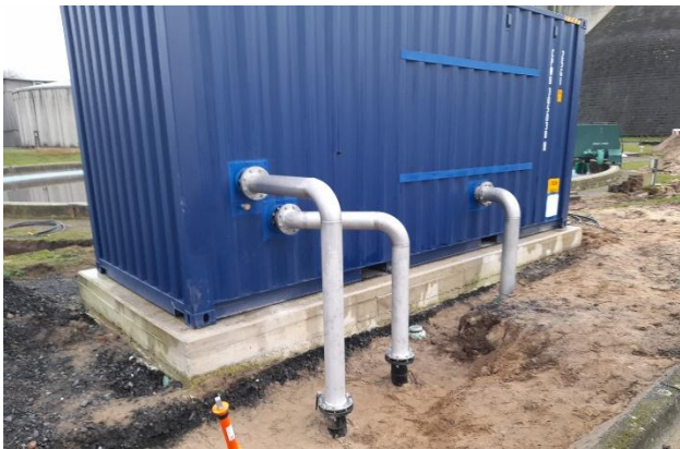
S::Select®-Anlage KA Borken (130.000 EW), Anschlussarbeiten Rohrleitungen
