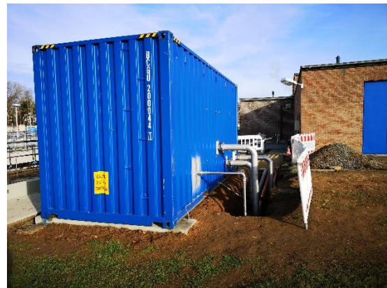
S::Select®-Anlage KA Schweinfurt (130.000 EW), Anschlussarbeiten Rohrleitungen, mit Betriebs- wasser, nur 2 Streifenfundamente
